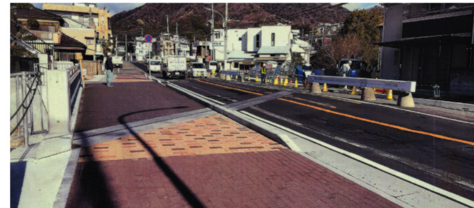
写真:2019.1.16明神橋架替工事が終了
